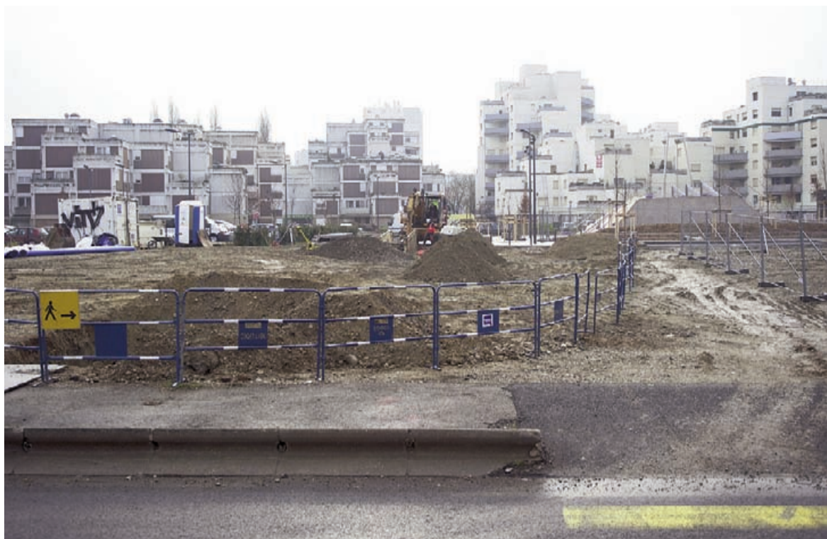
Les dalles de parking de l'avenue Salvadore Allende ont été démolies et laisseront place à des immeubles.
